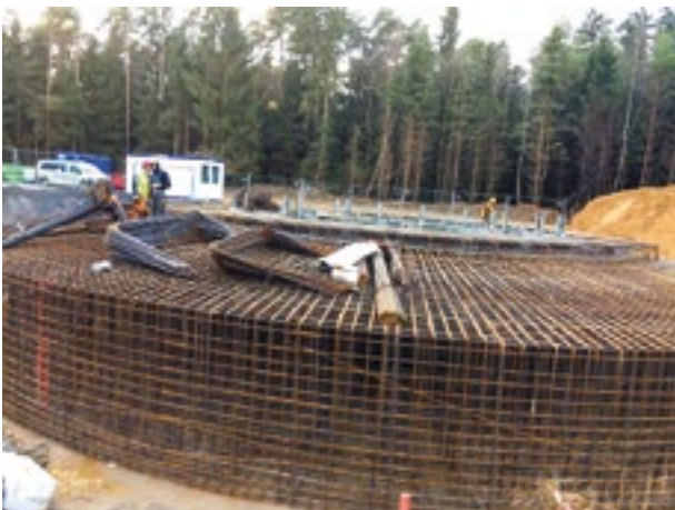
Bau des Fundamentkorbs HW7
